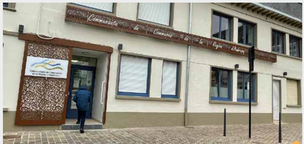
LA NOUVELLE FAÇADE EN TRAVAUX
