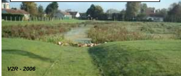
Bassin de rétention de type zone humide, sur la commune de Fréthun
